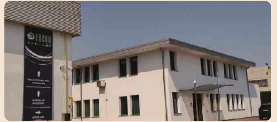
Sede di Energy Spa
