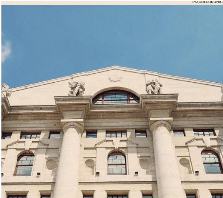
Piazza Affari. Palazzo Mezzanotte a Milano, sede della Borsa Italiana
